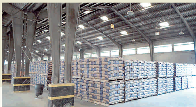
Centro de Distribuição
