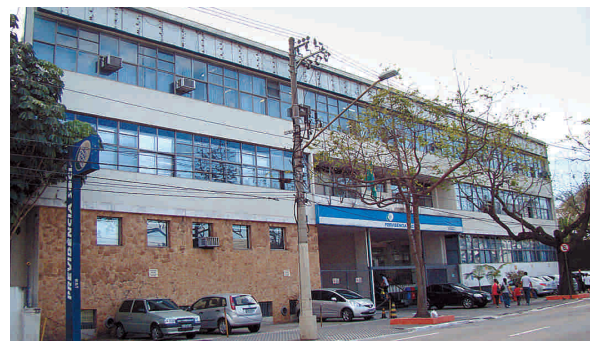
Prédio que abriga a gerência executiva do INSS e a agência da Previdência Social em São José dos Campos
